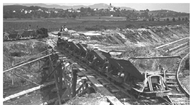
Meliorationsarbeiten im Gossauer Ried, 1943. [2, 3]
