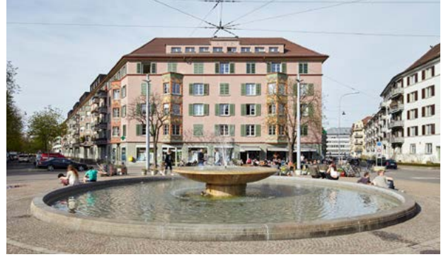
ABZ-Mehrfamilienhäuser im Sihlfeld, erbaut Ende der 1920er Jahre. [5]
