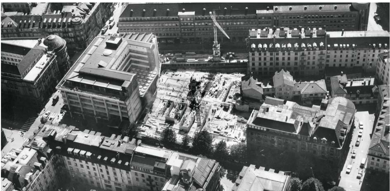
Der alte Hauptsitz ist abgebrochen, die zweite Bauetappe (1966–1970) hat begonnen. [5]
