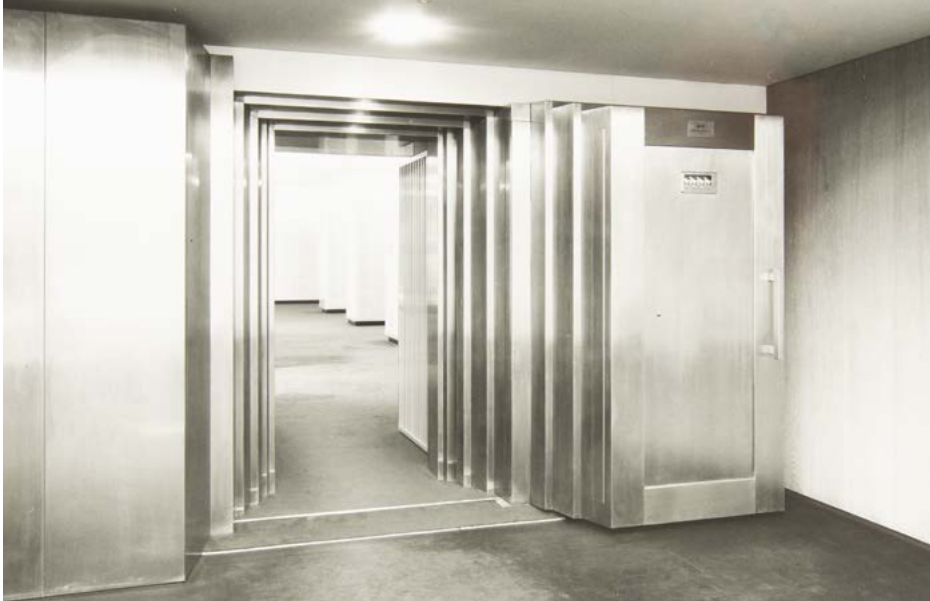
Türe zum Tresorraum in einer Filiale, 1970. Solche Türen wogen mehrere Tonnen.
