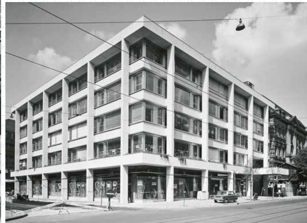
Die erste Bauetappe für den neuen Hauptsitz (1960–1964) ist in vollem Gang (rechts oben). Die erste Hälfte des Neubaus ist bezugsbereit. Der alte Bankbau von 1902 steht noch (rechts unten). Der alte Hauptsitz ist abgebrochen, die zweite Bauetappe (1966–1970) hat begonnen (links).
